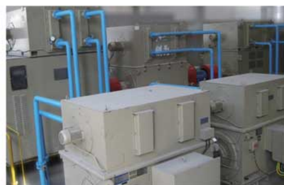
• Группа мотор-генераторов
